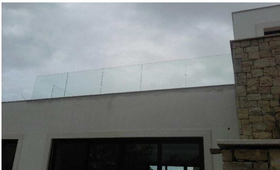
Vidro laminado aplicado com calha F100 embutida Moradia – Cascais
